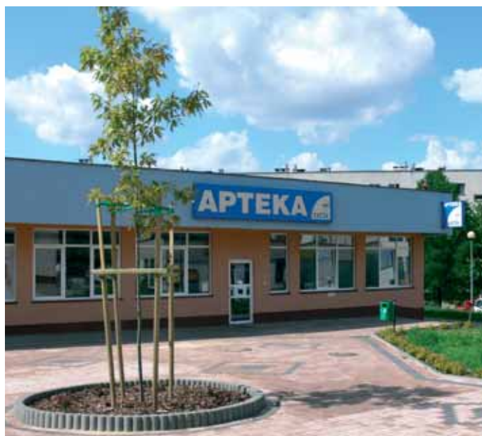
Remont elewacji oraz placu przed apteką przy ul. Warszawskiej 149a
